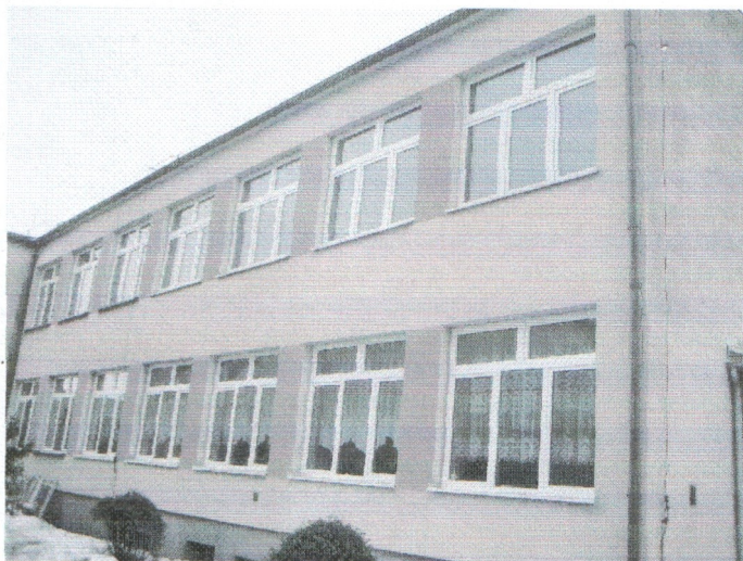
Zdjęcie nr 1. Widok frontowej elewacji budynku.
